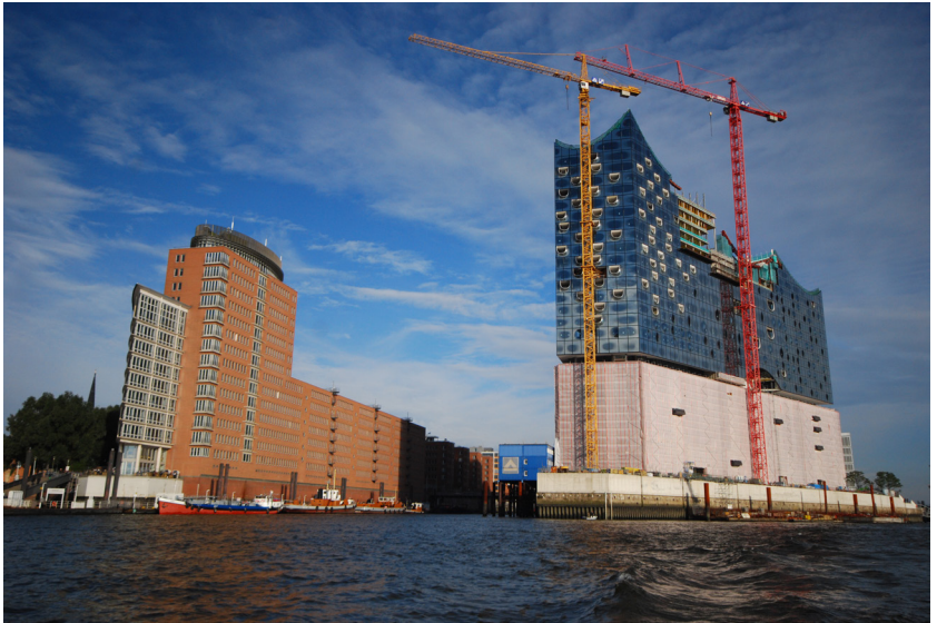
Elbphilarmonie en chantier.
